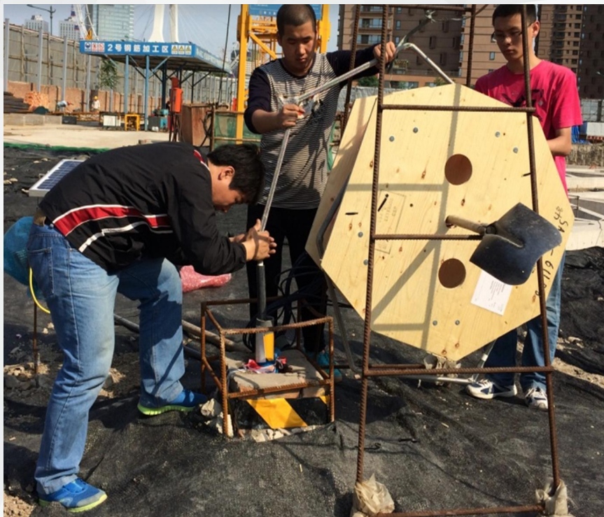
竖向布设-监测设备装入测斜管
